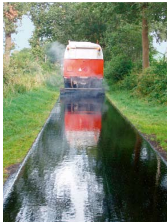
Verlegung der Teststrecke Hochdonn
